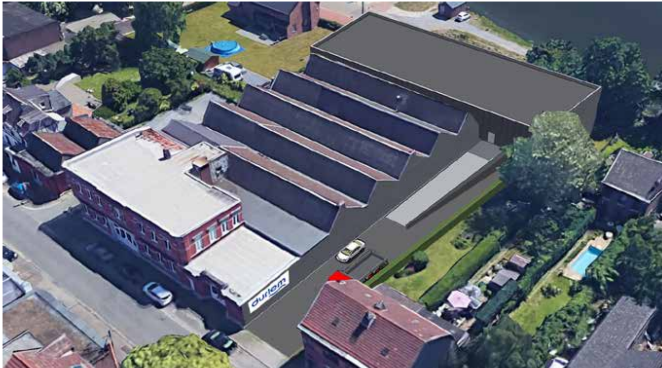
Durllem va doubler sa capacité de production en 2018 ; l'entreprise disposera pour ce faire d'un site de production agrandi et modernisé.
