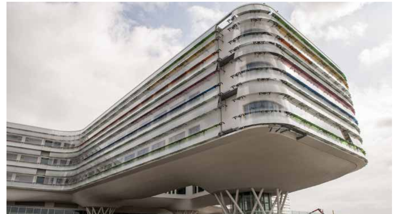
L'hôpital "flottant" repose sur une structure portante faite de colonnes en acier en treillis. (Photo: AAPROG-BOECKX-B2Ai)
