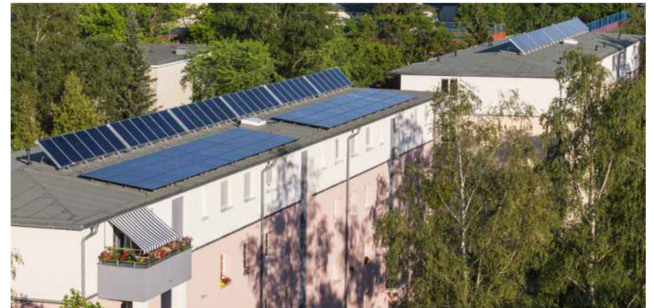
Le projet de la société de logements sociaux Märkische Scholle à Berlin démontre la faisabilité d'une rénovation éco-énergétique d'anciens quartiers résidentiels. (Photo: Sergey Kleptcha)
