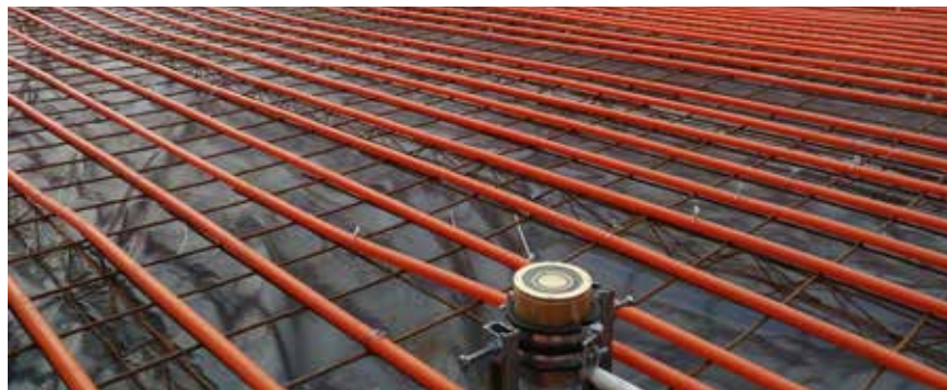
Pour la régulation, on a utilisé un détecteur de glace (l'appareil rond à l'avant de l'image). (Photo: Radson)
