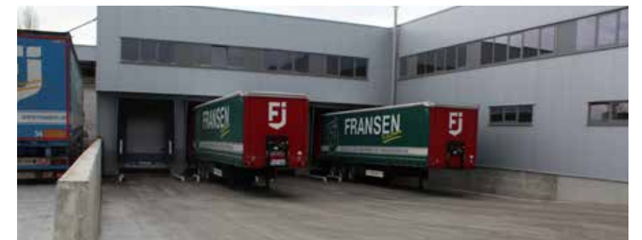
Dans le nouveau siège de l'entreprise de transport Fransen à Putte, la voie d'accès reste exempte de givre, grâce à un système Radson posé par l'entreprise d'installation Invatral.
