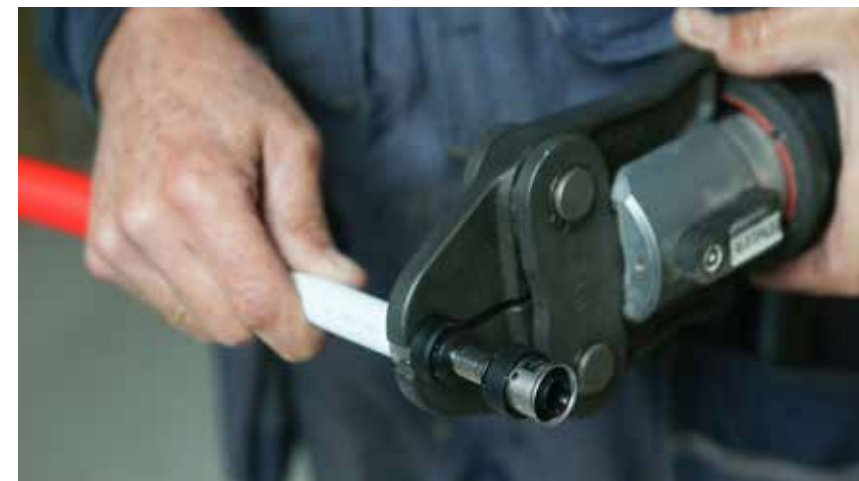
L'absence de joint torique facilite le montage : il suffit d'insérer le raccord à la bonne profondeur et ensuite de le sertir.
