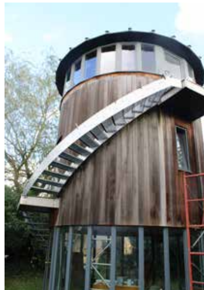
La tour de guet de la ferme rénovée sert aujourd'hui de chambre d'ami.
