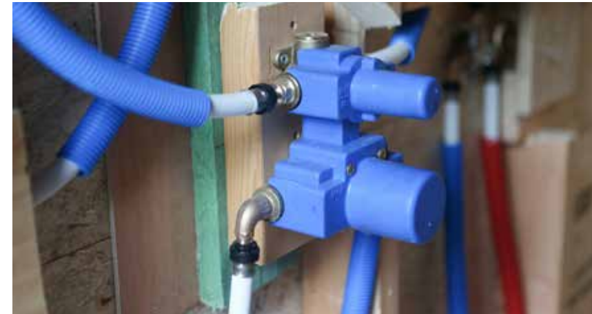
Caractéristique des raccords Smartpress : aucun joint torique n'est nécessaire.
