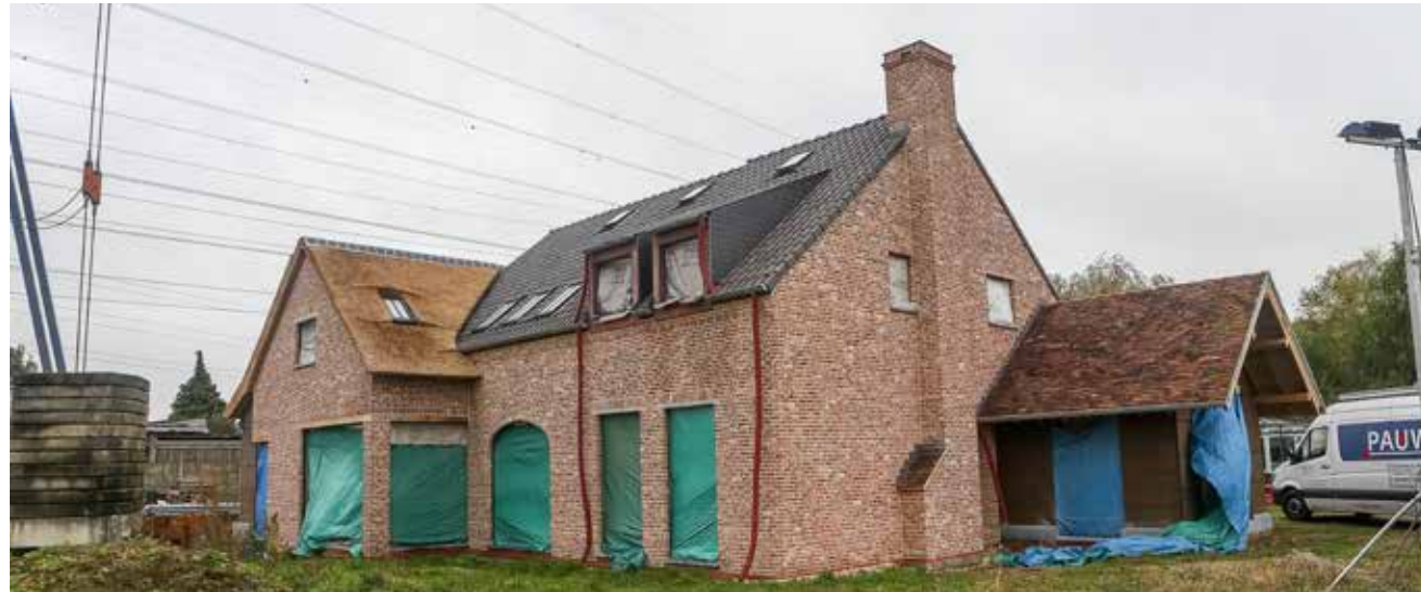
Le système innovant Smartpress a été appliqué dans une construction à ossature bois à Beveren-Waas.
