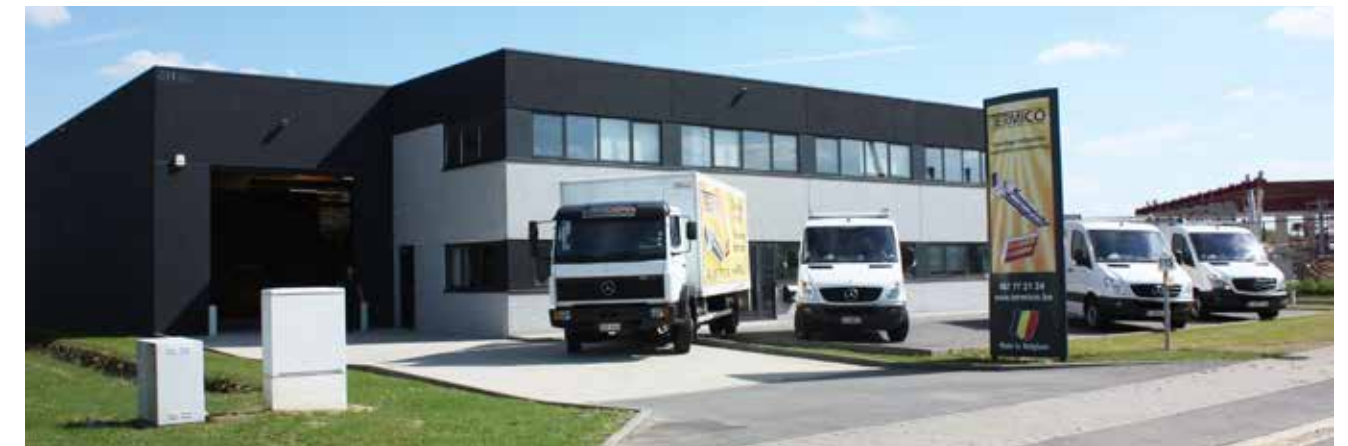
L'entreprise belge Termico est installée depuis 2012, dans le zoning industriel de Nivelles. (Photo : Termico)
