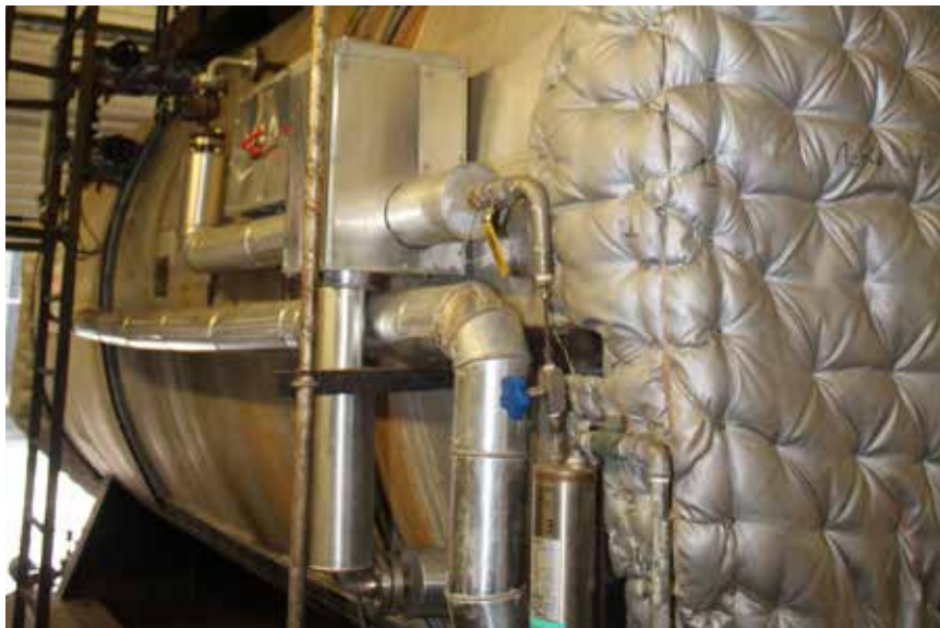
Indien nodig kunnen de stoomketels bijspringen om ook warmte te leveren.
