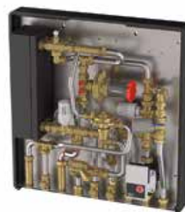
Versie bi-temperatuur : installaties met hoge en lage temperatuur
