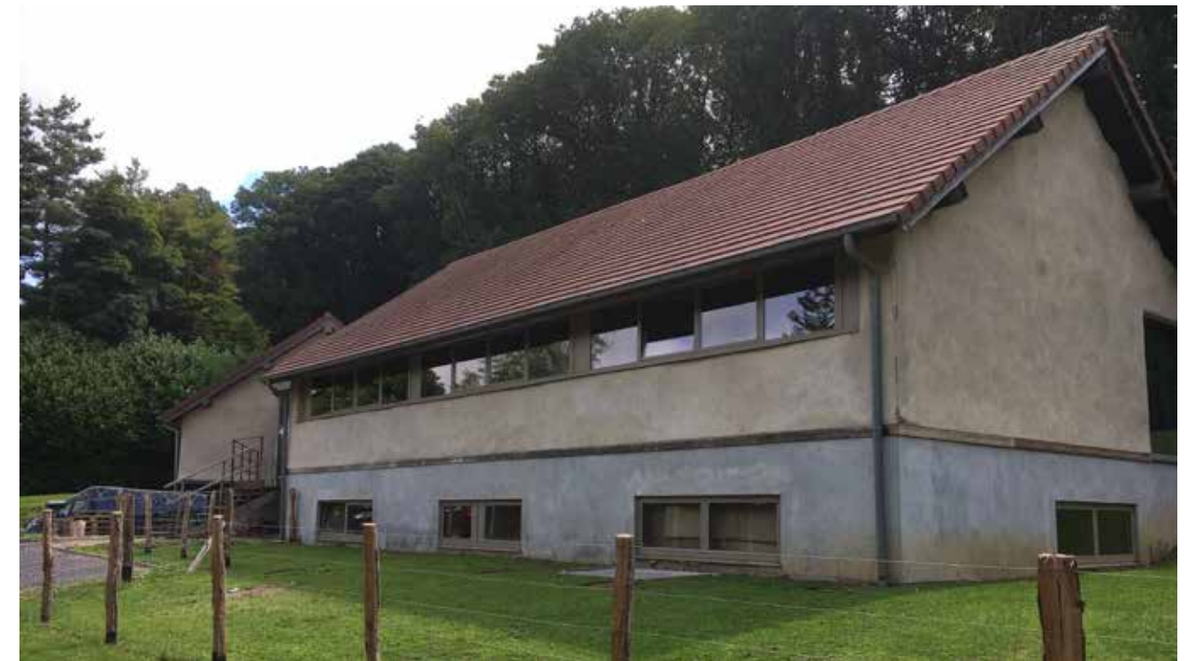
De woning bestaat uit twee gedeeltes, verbonden door een gang. In het woongedeelte (hier zichtbaar) bevinden de slaapkamers zich op de benedenverdieping, met vensters net boven het grondniveau. De woonruimte neemt de hele bovenverdieping in. (Foto: Stiebel Eltron)
