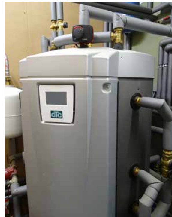
De CTC EcoZenith i550 Pro is een alles-in-1 buffervat van 540 liter met een geïntegreerde sturing en een isolatiemantel van 90 mm polyurethaanisolatie voor minimaal warmteverlies.
