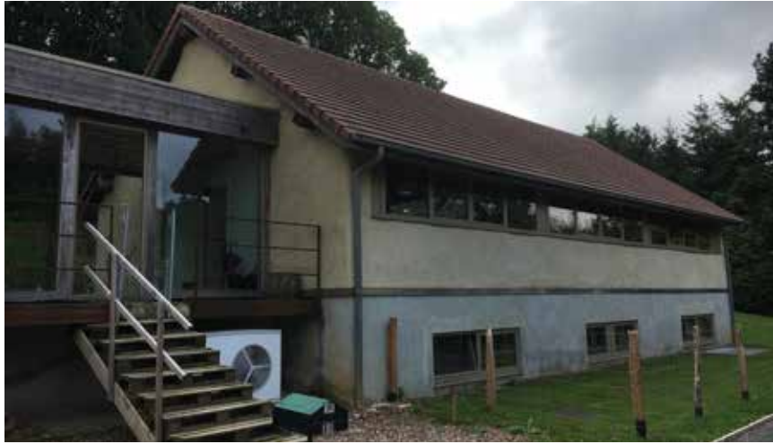
Het buitendeel van de Stiebel Eltron WPL25 werd in een inham aan de voorkant geplaatst. (Foto: Stiebel Eltron)
