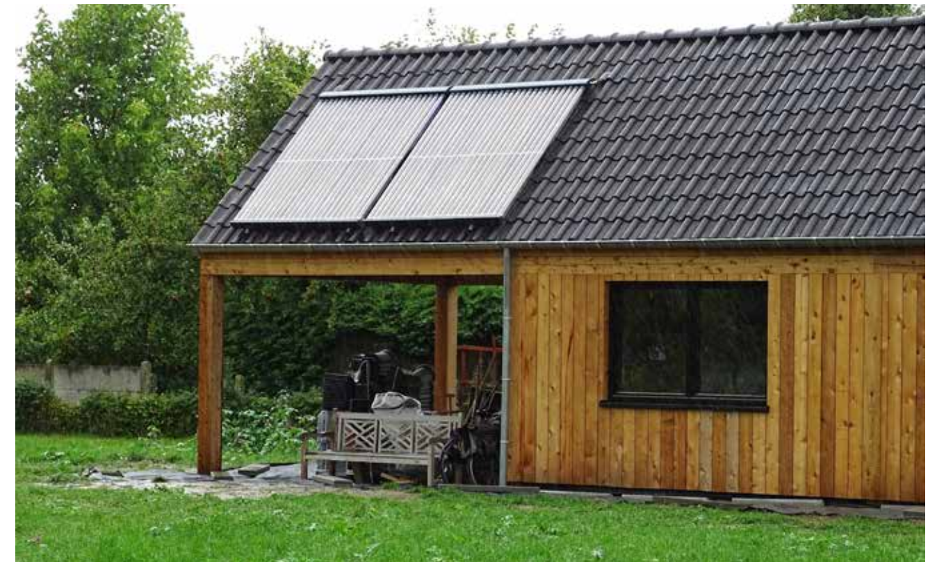
2 x HP24 EnerSol zonnecollectoren met hoogwaardige heat pipe vacuümbuizen onderscheiden zich door een hoge jaarbenuttingsgraad en zonne-energiebenutting met hoge werktemperaturen.
