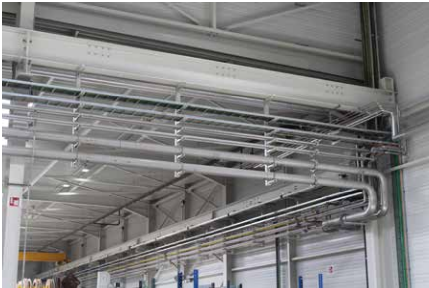
Als specialist in RVS kon installatiebedrijf Ventfield alle leidingen in dit materiaal uitvoeren.
