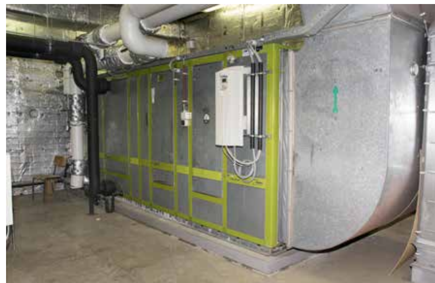
Les groupes de traitement d'air ont également été profondément rénovés.
