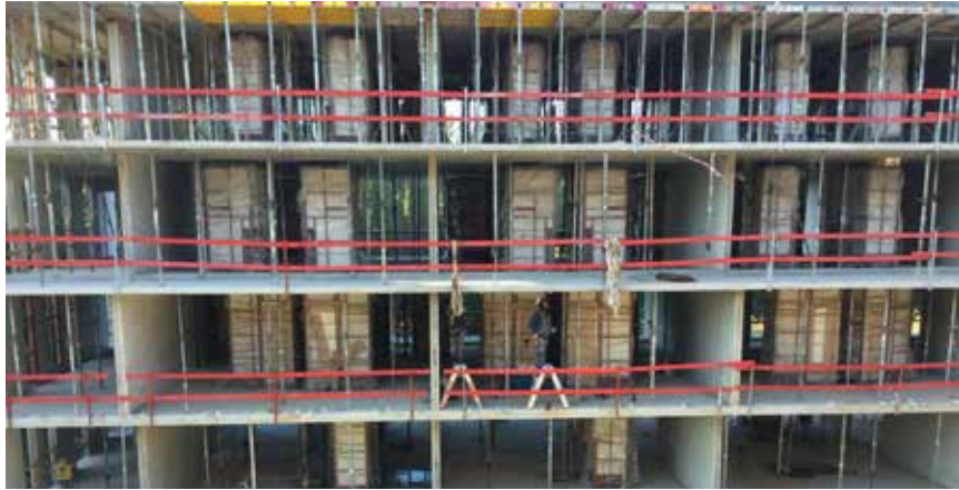
Les locaux compacts ont été le principal défi durant l'installation.
