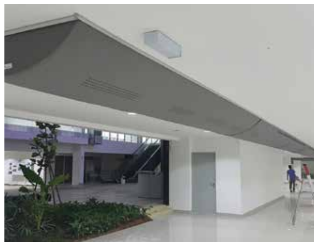
Les gaines textiles offrent une solution idéale pour chauffer et refroidir des halls polyvalents.
