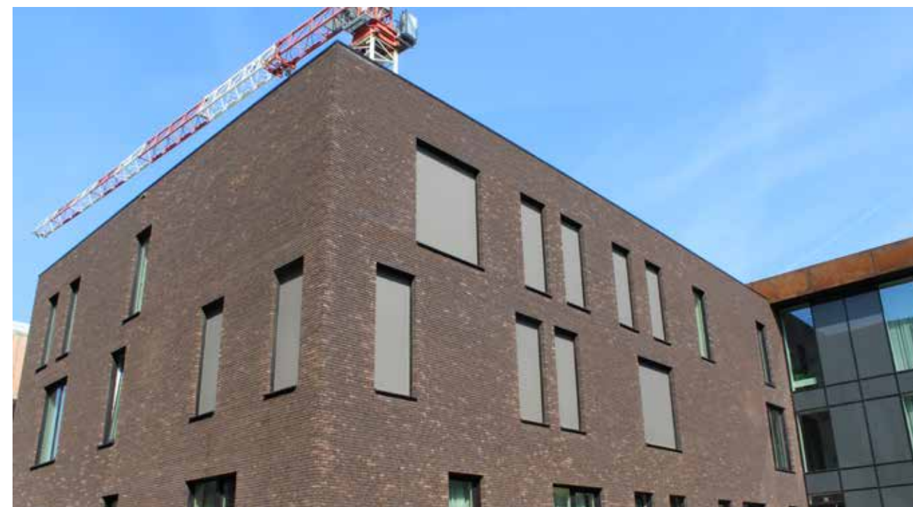
L'installation assure le chauffage et le refroidissement de la nouvelle maison de repos sur le site du Heilig-Hartinstituut à Heverlee (Louvain).
