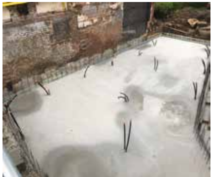
Les échangeurs de chaleur dans les pieux ont été raccordés à un collecteur.
