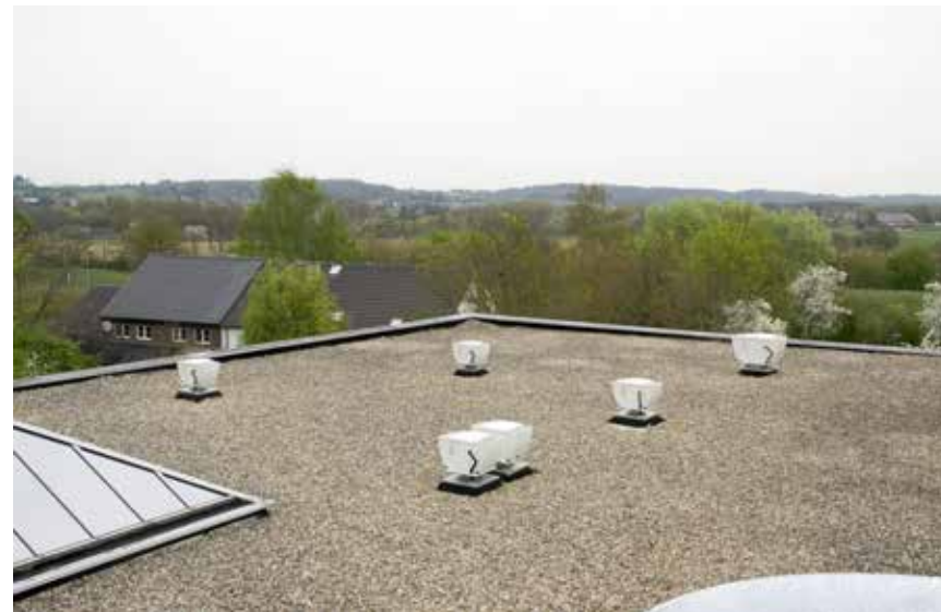
Afin de favoriser l'extraction dans les laboratoires, DencoHappel a livré des tourelles d'extraction RoofJET.
