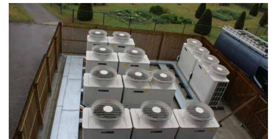
Les unités extérieures ont été installées en trois groupes ; elles ont par ailleurs été camouflées à l'aide d'une clôture.
