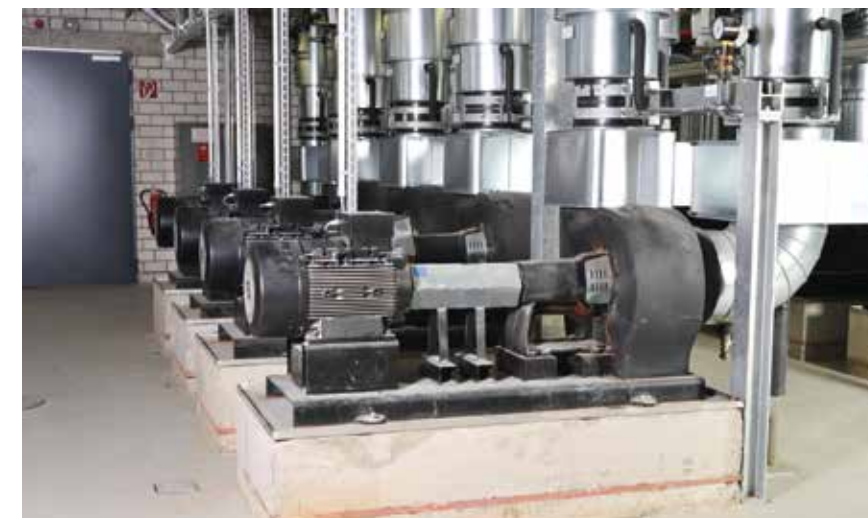
Un des collecteurs principaux dans un complexe de salle d'exposition avec des pompes normalisées de la série NK.
