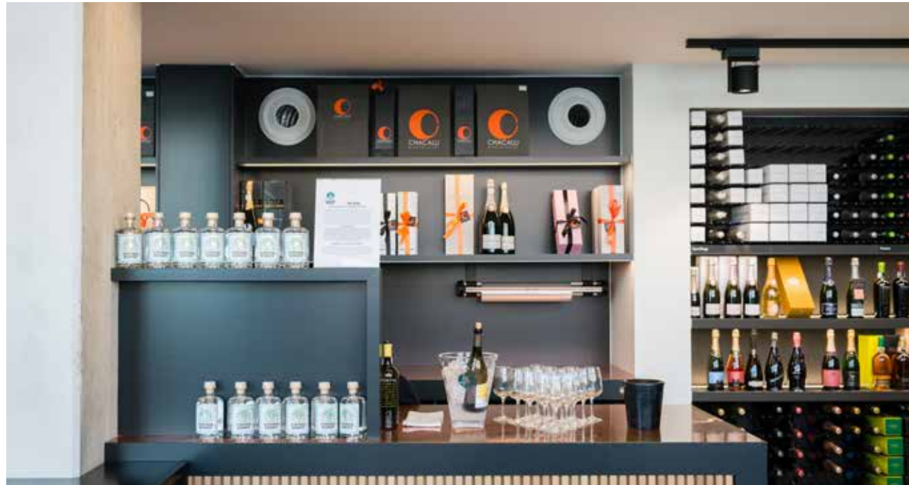
Les bouches des gaines de ventilation ont été élégamment camouflées dans l'intérieur.
