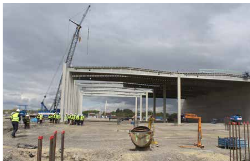
Le bâtiment sera totalement autosuffisant en matière de consommation d'eau.
