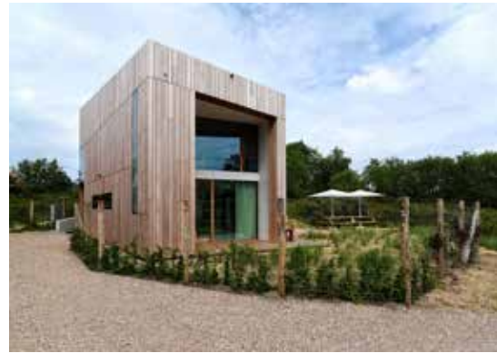
Le système DucoTronic Plus permet de surveiller le climat intérieur et de commander la ventilation de l'habitation de vacances Kabano à Oostduinkerke.
