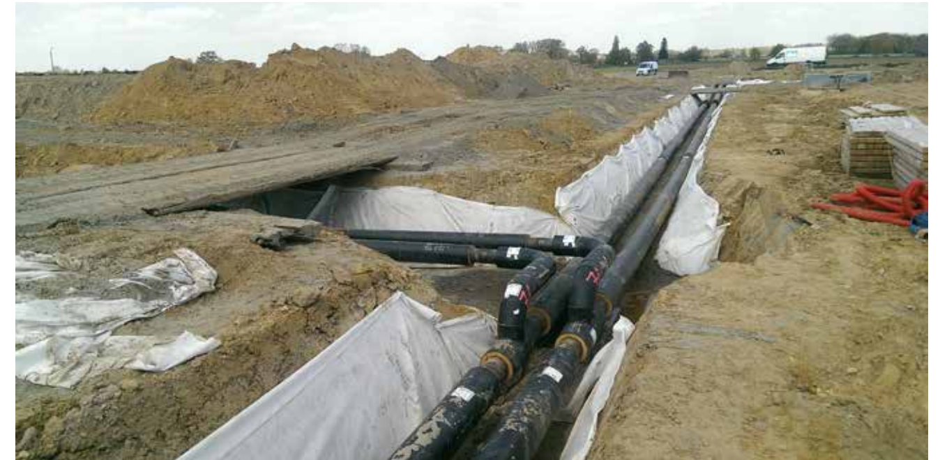
Pose du réseau de chaleur dans la zone PME, en 2016. (Photo : Mirom)
