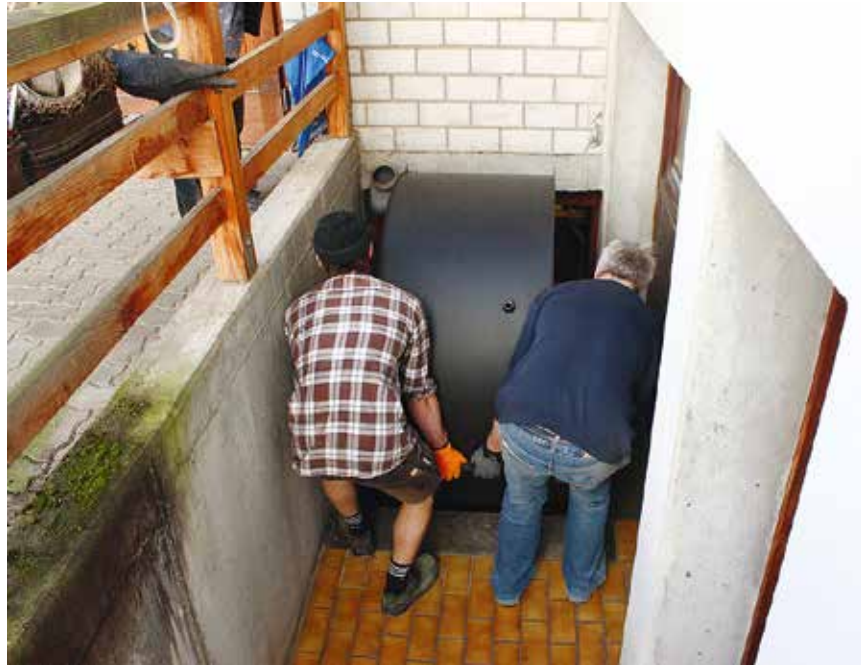
Figure 3A: Un module est transporté dans la cave à travers une embrasure de porte étroite.
