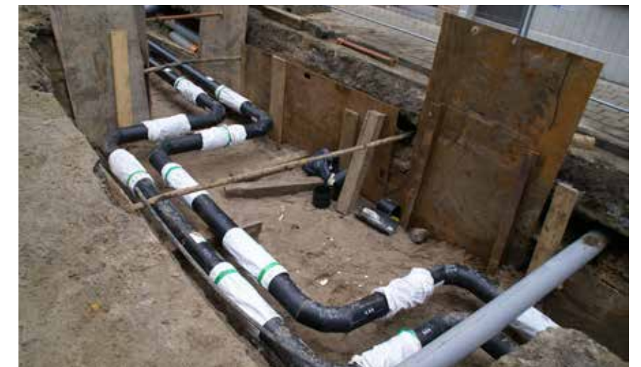
Une partie du réseau de chaleur, posée à travers le centre-ville de Roulers. (Photo : Mirom)
