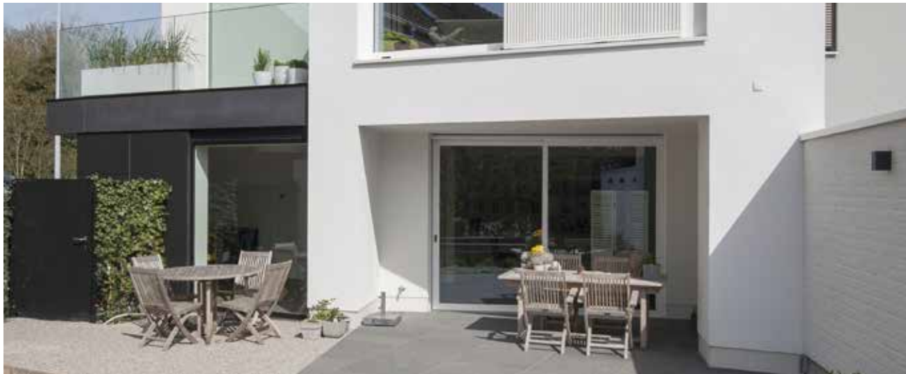
Le maître de l'ouvrage a opté pour un concept total de ventilation naturelle à la demande, avec le DucoTronic Plus System comme point de départ.
